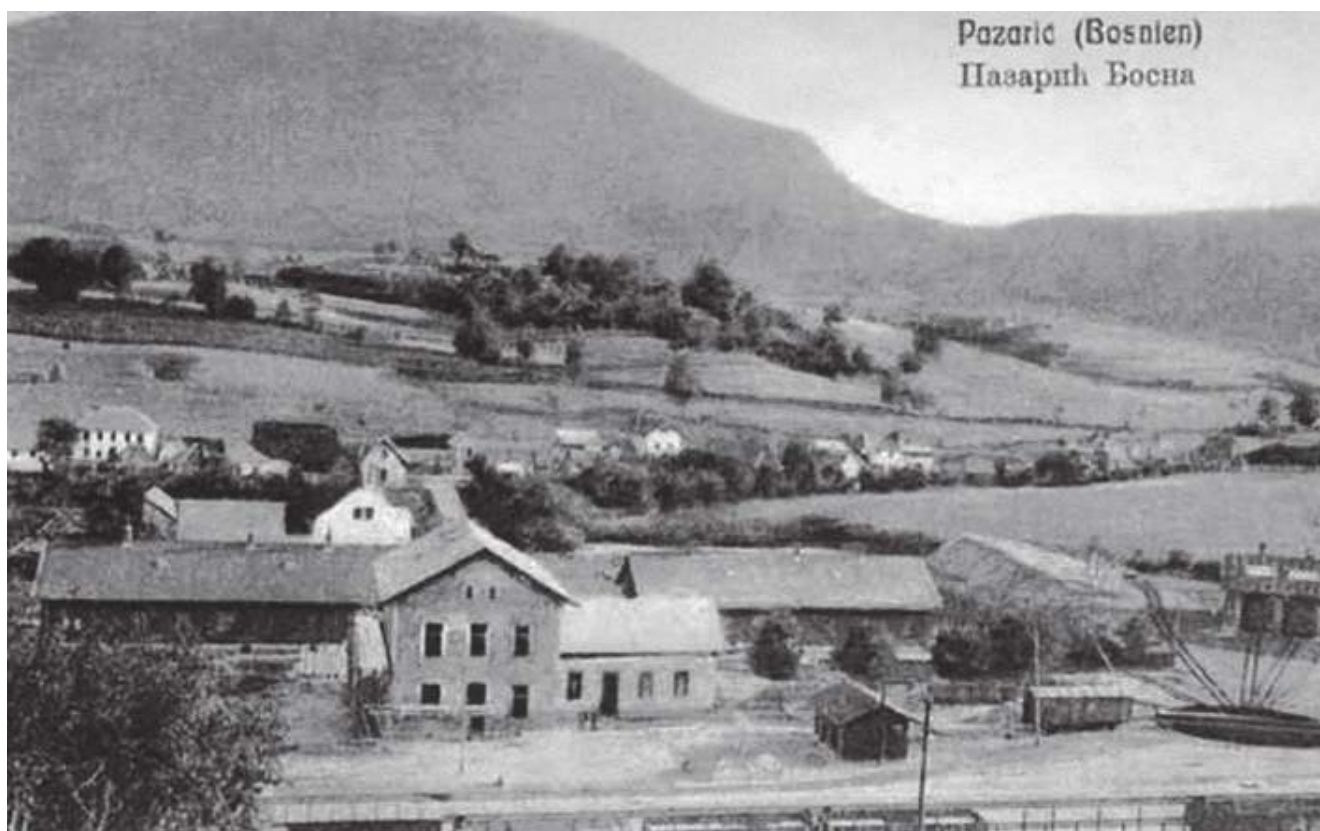
Slika br. 130 Željeznička stanica Pazarić u izgradnji sa okretaljkom i depoom za lokomotive.
