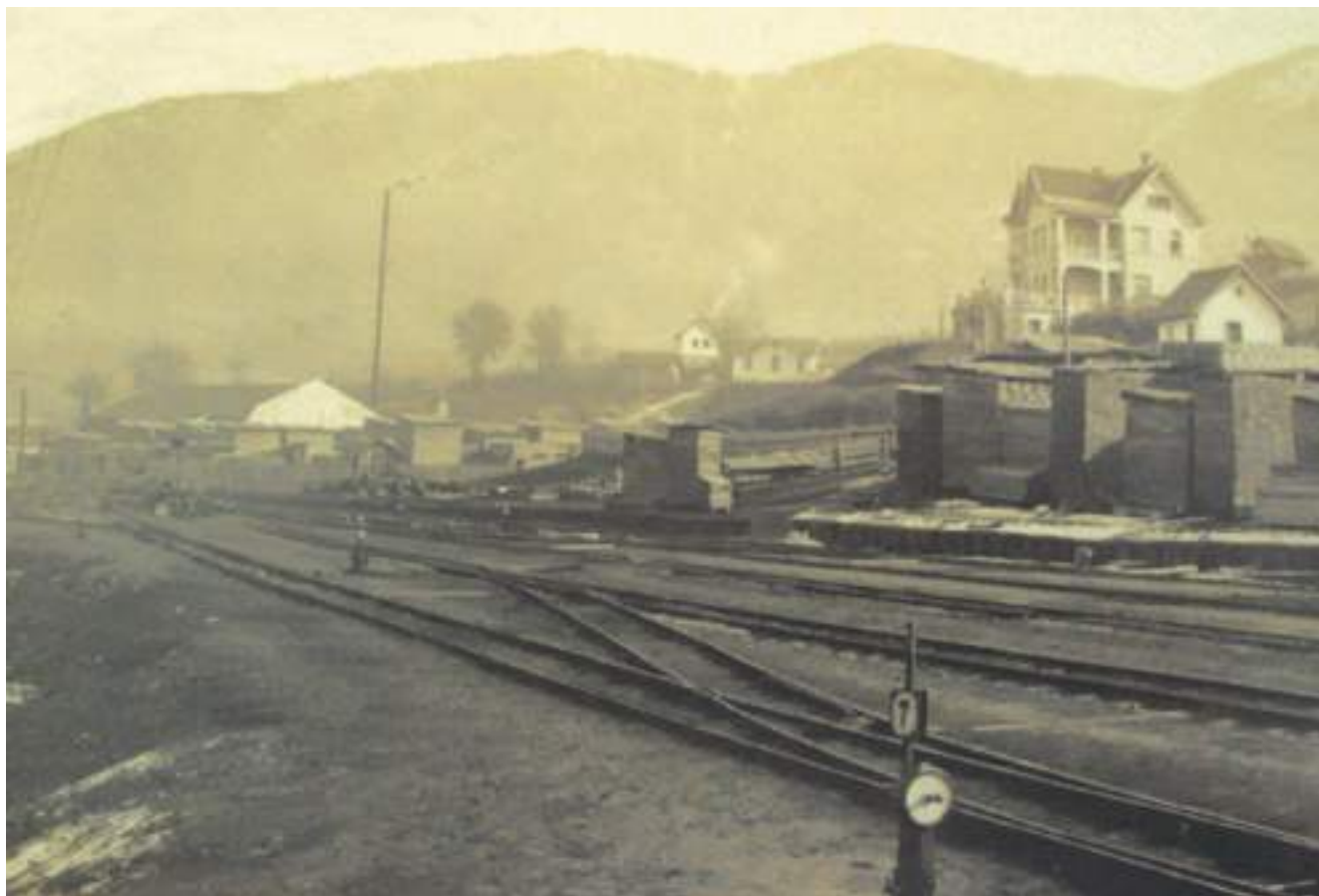
Slika br. 145: Pilana i vila Kašikovića u Hadžićima uz željezničku stanicu.
