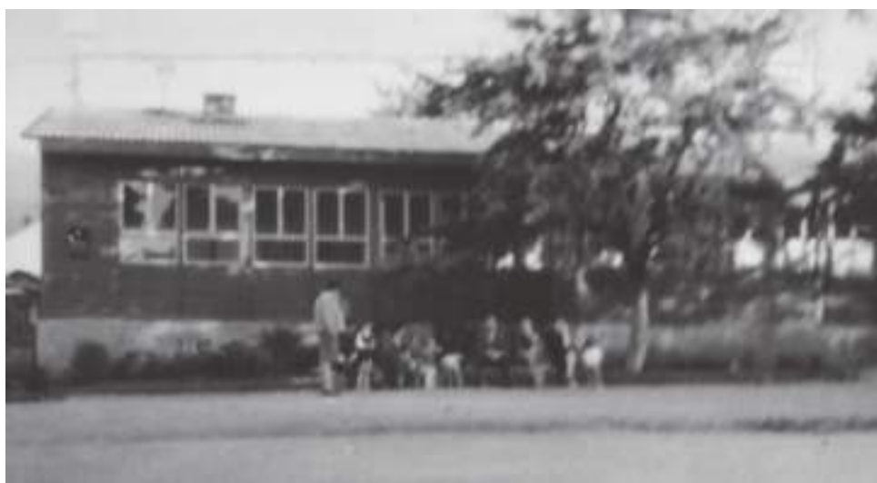
Slika br. 215: Aneks OŠ “Bratstvo i jedinstvo” Tarčin (drvena zgrada), 1962.
