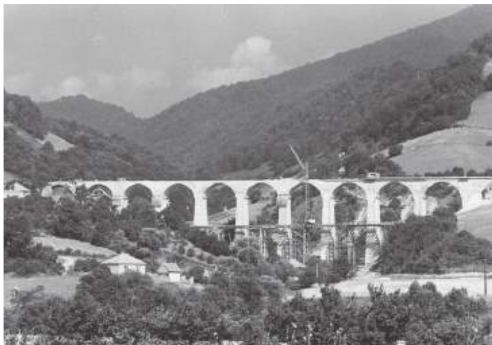
Slika br. 204: Željeznički most u selu Do-Tarčin, u izgradnji, 1965.
