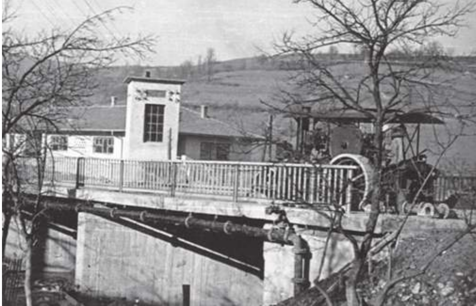
Slika br. 239: Dom zdravlja „5. april“ Hadžići u pozadini mosta i trafostanice, 1970. godine.
