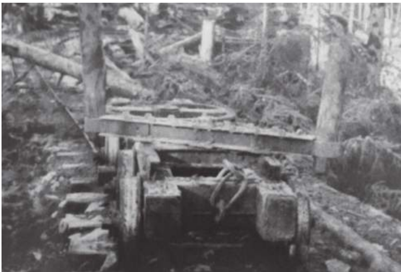
Slika br. 143: Izgled šumskih vagoneta na gravitacionoj šumskoj pruzi Hadžići-Igman.
