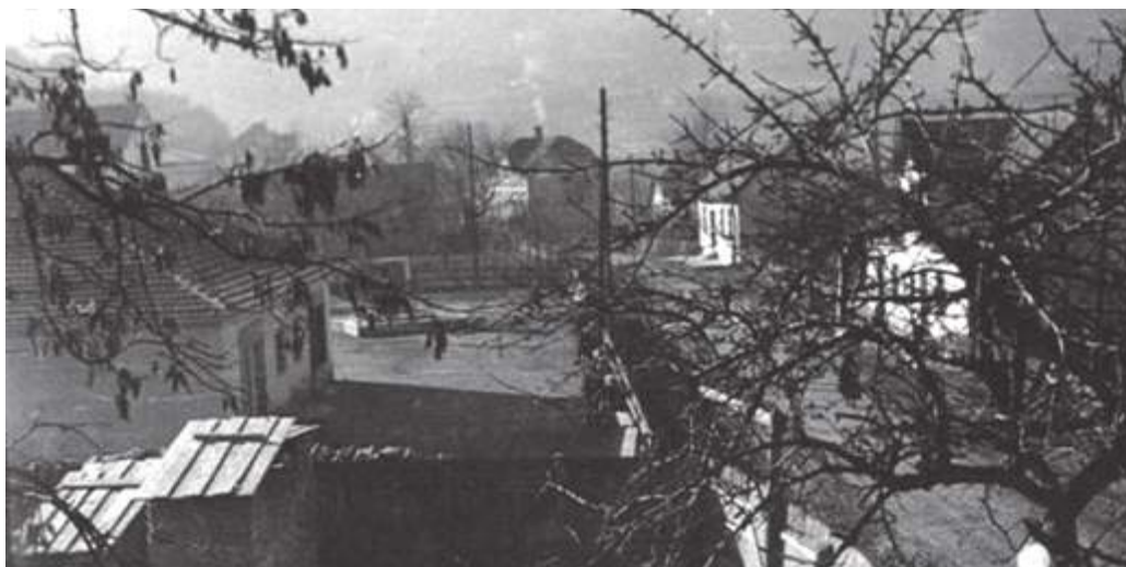
Slika br. 187: Pogled na centar Hadžića 1960. g. (dio stare pilane, zgrada Zadruga i dr.)
