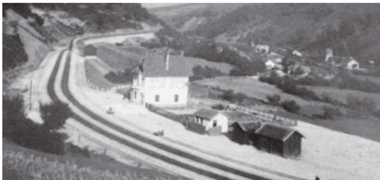
Slika br. 167: Željeznička stanica Raštelica otvorena 9.4.1931.
