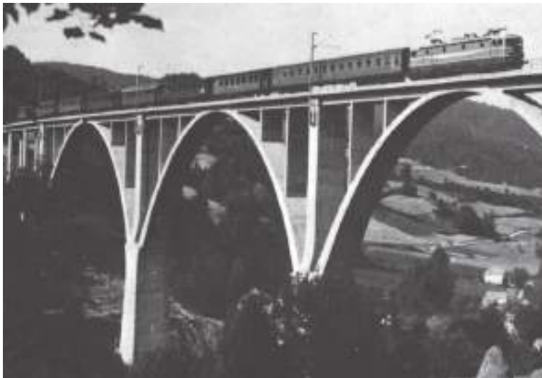
Slika br. 205: Željeznički vijadukt Smucka-elektrificirana pruga, 1969.
