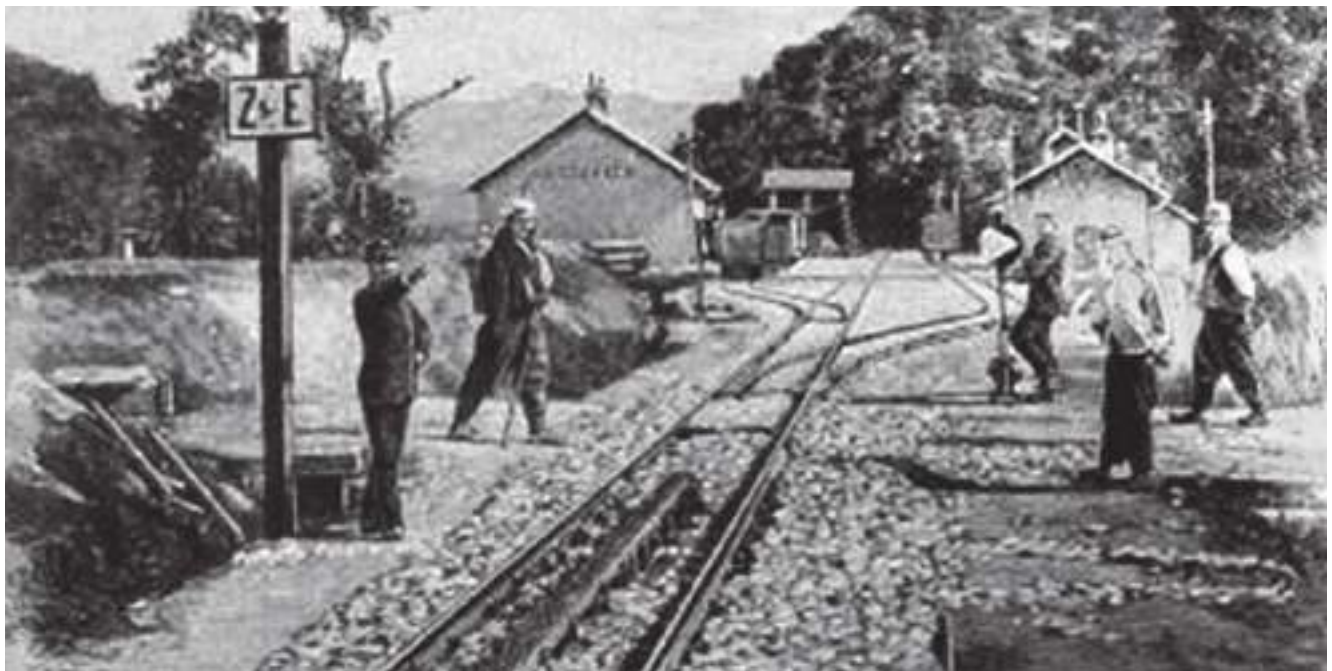
Slika br. 132: Izgradnja prve željezničke stanice u Raštelići 1890.
